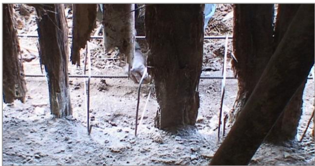
Die grosse Überraschung bei der Renovation
