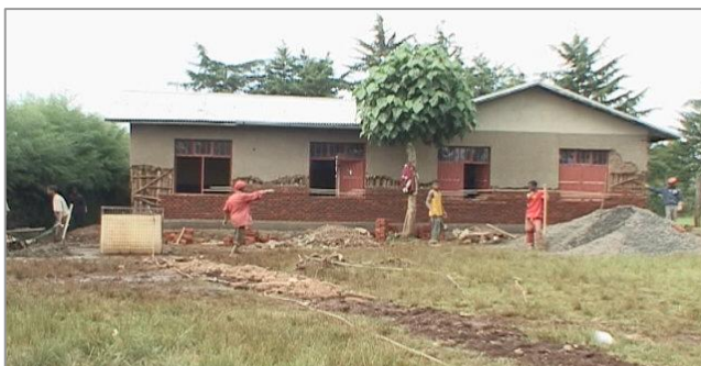
Während der Sanierung
