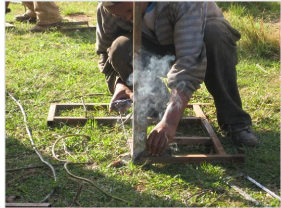
wurden Vorort repariert.....
